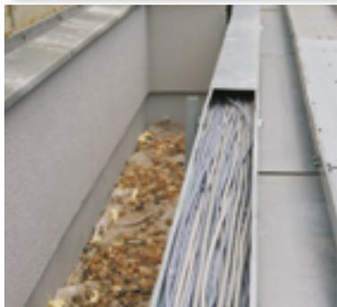
Metallkabeltrassen sind ein universelles Tragsystem für eine Vielzahl an Kabeltypen (vom Stark- bis zum Schwachstromkabel).
