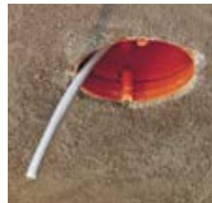
Dose KBT... mit herausgeführter Leitung, vorbereitet für Deckenhaken Montage KBP...
