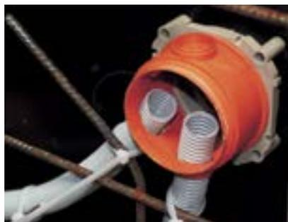
Biegsame Rohre montiert ins Gehäuse KBT.
