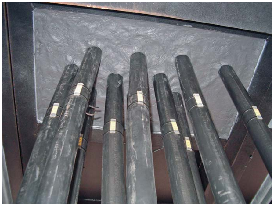
FIWA - fertiges Brandschott EI 90, E 120
